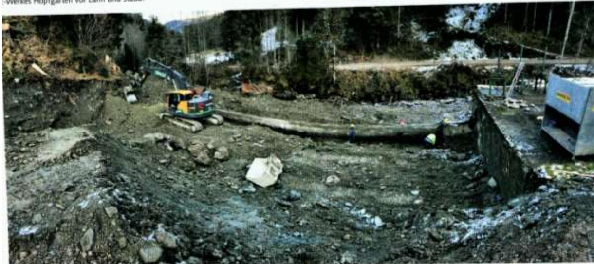
Die bestehende Wehranlage wurde bereits freigelegt, damit die Betonarbeiten für die neue Wasserfassung durchgeführt werden können.
